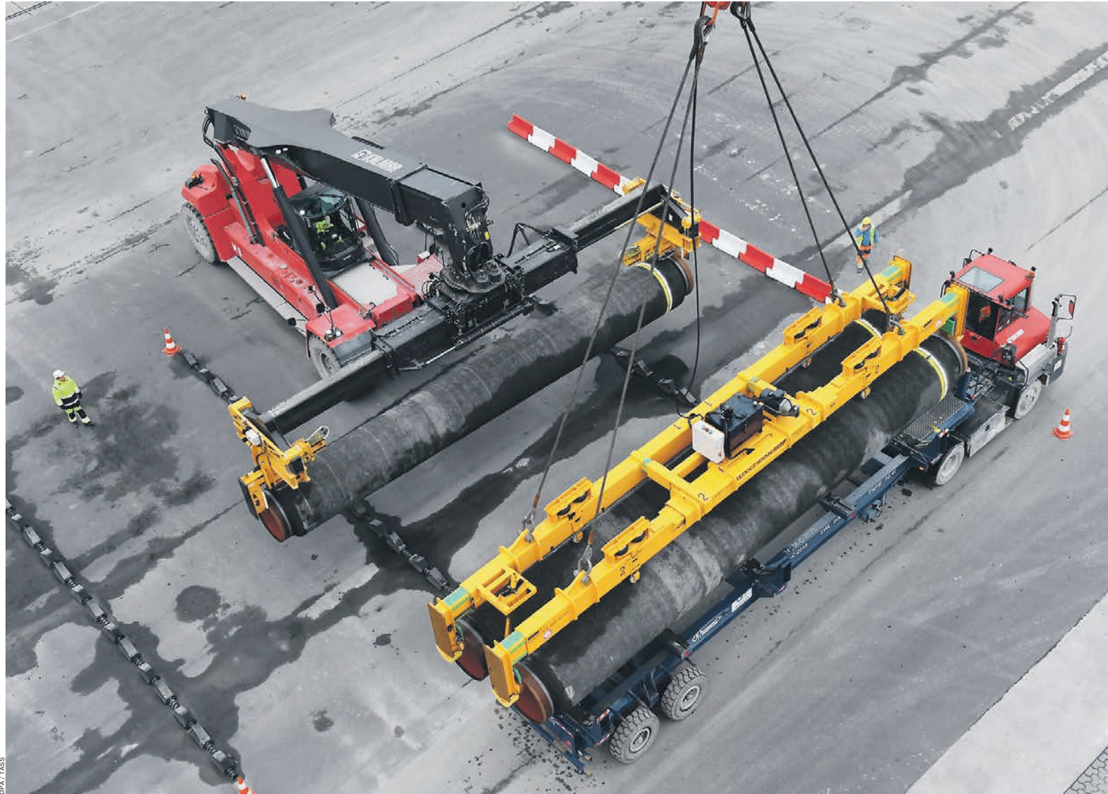
«Северный поток-2» готовится, но пойдут ли по этим трубам газ — вопрос, пока не имеющий окончательного ответа
